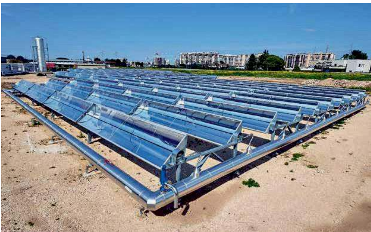
La instalación de Absolicon con la cervecería Birra Peroni en Bari, Italia, produce vapor y agua caliente a presión para los pasteurizadores
