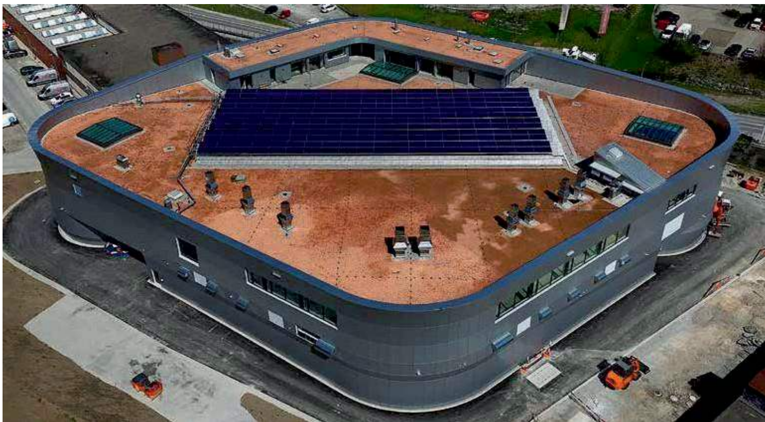
En la planta industrial de Carrosserie Pfister en Herisau, Suiza, los colectores fotovoltaicos-térmicos (PVT) descubiertos generan 106 kWp de energía eléctrica y 324 kW de potencia térmica Foto: Aldrian Althaus, soblue AG
