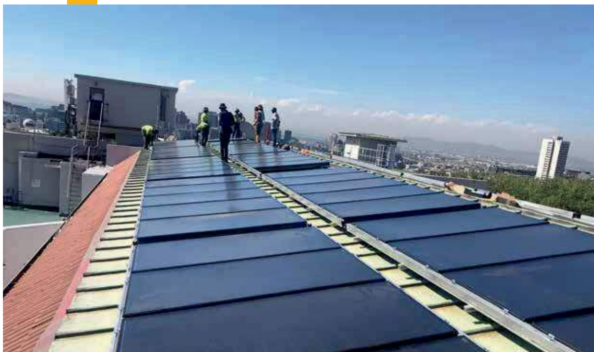
Green Line Africa, socio de SOLTRAIN, instaló colectores PVT acristalados de 196 m 2 (137,2 kW térmicos, 44,0 kW eléctricos) para ACS en un hospital privado de Ciudad del Cabo
