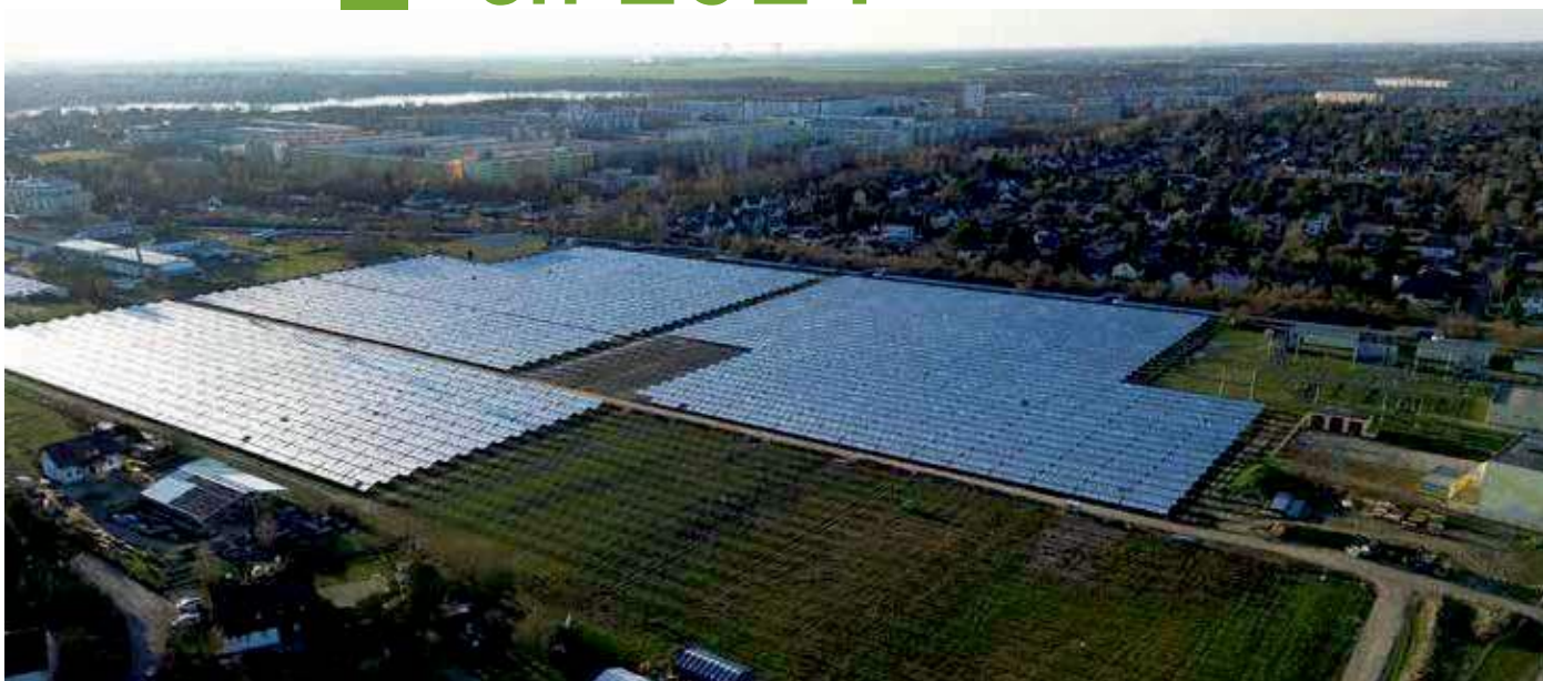
Planta de calefacción urbana solar de 65.000 m 2 en construcción en Leipzig, Alemania
