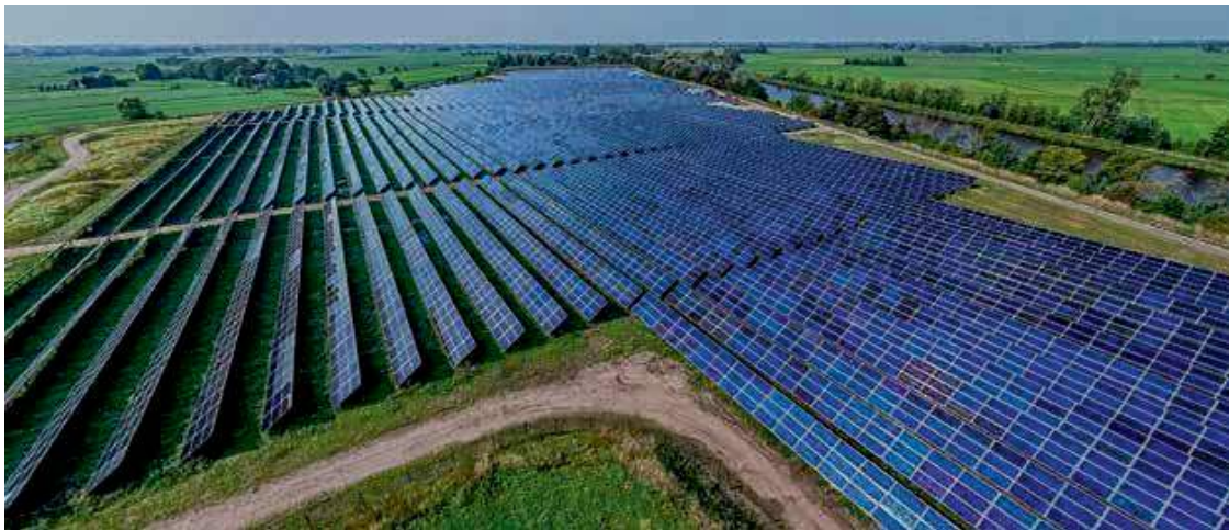
La superficie de colectores de 48.800 m² (34 MW) puesta en marcha en 2024, suministra calor a una red de calefacción urbana en Groningen, Países Bajos. Ocupa el cuarto lugar en cuanto a área de colectores para sistemas de calefacción urbana en todo el mundo, Foto: TVP Solar
