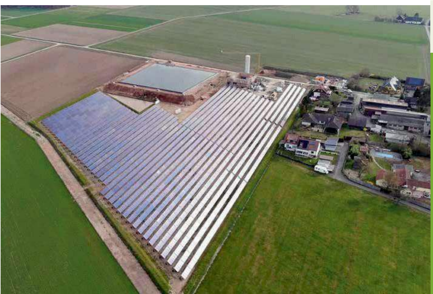
Bracht – calefacción urbana 100% renovable, 11.637 m 2 de área de colectores (7,5 MW) y 26.600 m 3 de almacenamiento térmico estacional de pozo que proporciona entre un 75 y un 80% de fracción solar en construcción en Alemania
